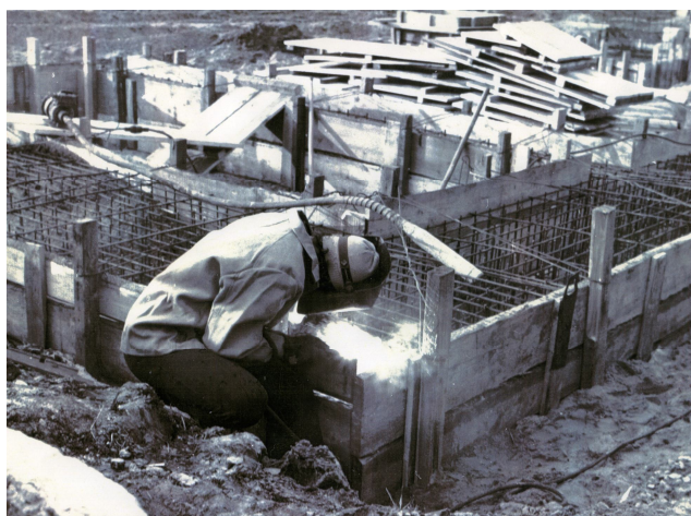
Закладка капсулы в фундамент Нового здания Библиотеки
