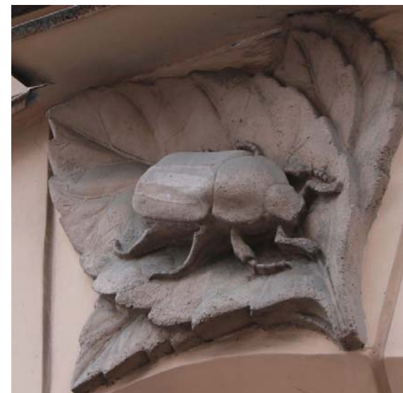
Майский жук – возрожденный барельеф на здании, где располагалась гимназия и реальное училище К. Мая.
